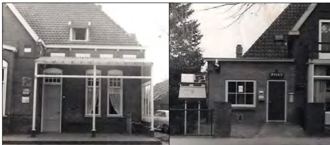
Afb. 4 en 5: De opeenvolgende postkantoren van Jan Wijns in de Stationsstraat.
